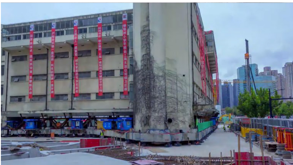
Рис. 10. Передвижка здания школы в Шанхае в 2020 году методом перемещения шагающего типа walking machine [6]
