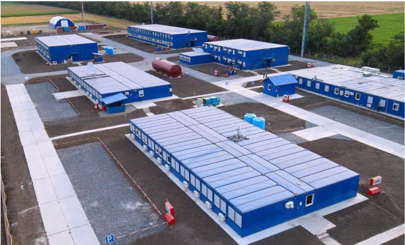
Стандартный вахтовый поселок, возведенный по модульной технологии
