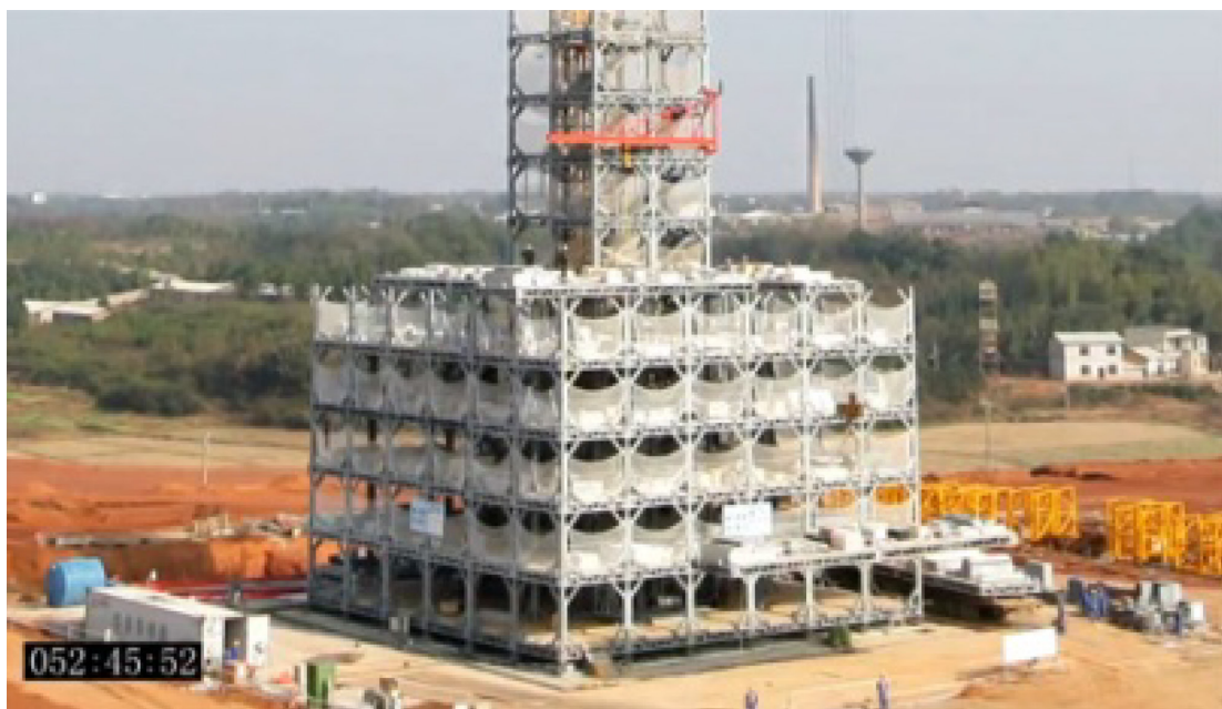
Рис. 2. Сборка несущего каркаса
