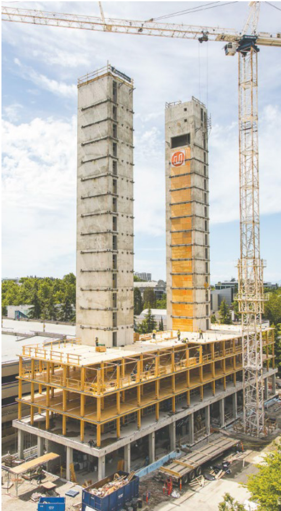
Рис. 4. Строительство здания по системе Träg
