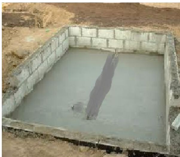
Рис. 3. Подходящее место для приготовления бетонной смеси вручную
