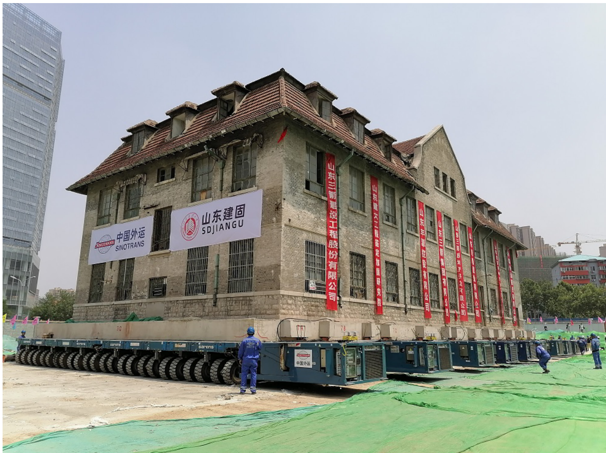
Рис. 11. Передвижка здания монастыря в городе Цзинань (Китай) при помощи SPMT-платформ [9]
