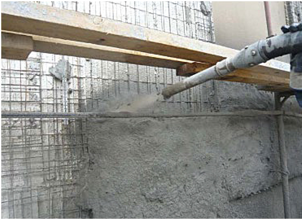
Рис. 4. Восстановление сплошных разрушений железобетонных конструкций методом торкретирования
