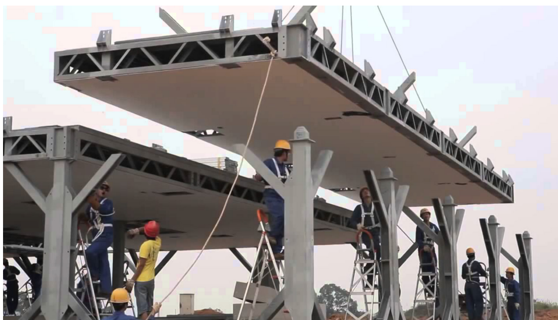
Рис. 3. Установка модулей плит перекрытия
