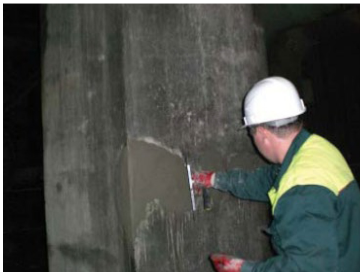
Рис. 3. Ремонт железобетонных конструкций ручным способом
